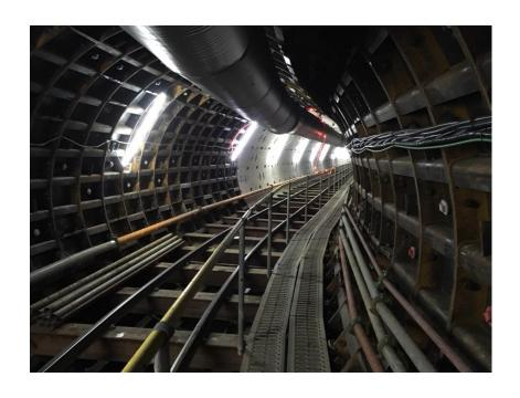
先日春の天皇賞を間近に控えた京都競馬場(淀)近くまで工事見学に出かけた。大都市部では下水道整備はほぼ終わっていると思われがちだが、田畑の宅地化による遊水機能の喪失と局地的な豪雨の頻発などによる雨水流出量の激増に耐えられなくなっている。下水道の重要な役割の一つである雨水排水(浸水防除)の能力増強のため道路の地下深く(この現場では地下20数メートル)で、人知れず昼夜兼行でトンネル工事が進められている。工事の始点、終点間2.2キロメートルを地上に顔を出すことなく地下に潜ったまま堀り進む。途中に数か所ある直角に曲がる交差点でも地上の交通に支障を与えないよう急曲線でそのまま掘り進む。
